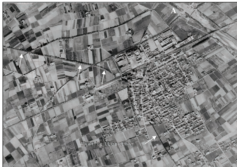
Figura 1 Vista aèria de l'any 1947. S'aprecia la línia del ferrocarril que configura un límit entre zona habitada i zona industrial. El pont de la futura C-246 (carretera de la platja de Castelldefels) encara en obres (A). S'aprecia la trama de canals i, especialment, el de la Dreta del Llobregat (assenyalat).
