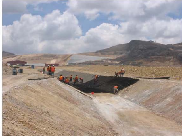
Instalación de geoceldas en un canal.
