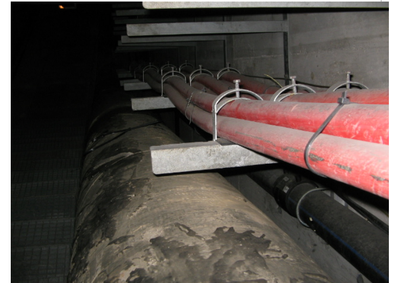
Ejemplos de instalaciones de red general de transporte en zanja o en galería de servicios
