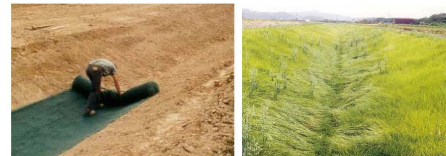
Imagen de canal de drenaje estructurado con geomalla permanente.
